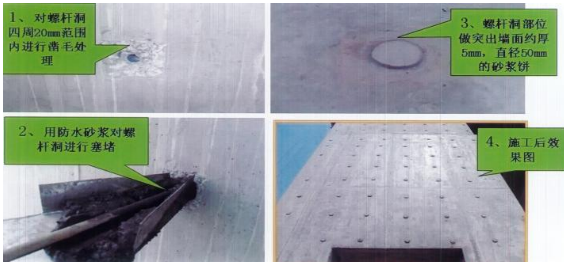
对拉螺栓孔封堵
