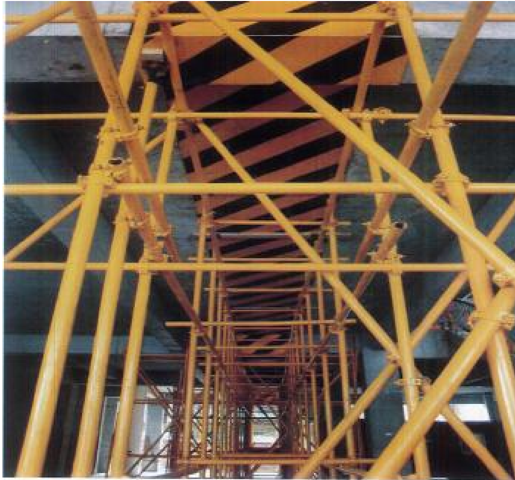
后浇带模板支撑系统须独立设置
