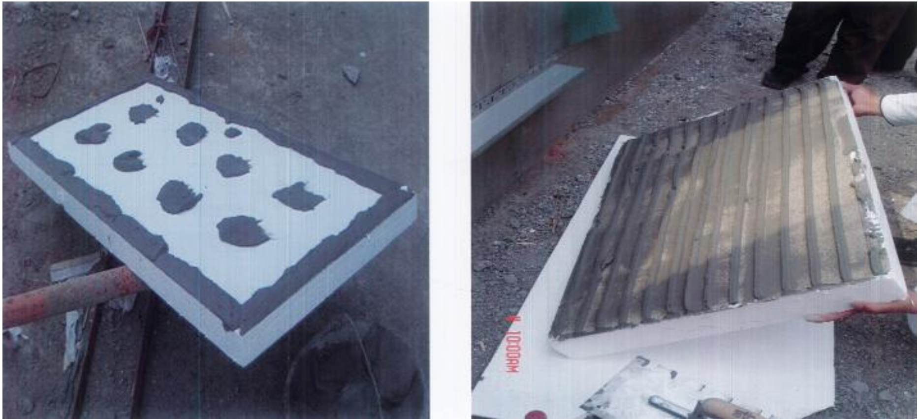
外墙保温板打胶样板
