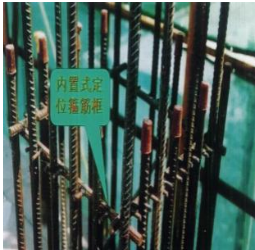
框架柱定位筋
