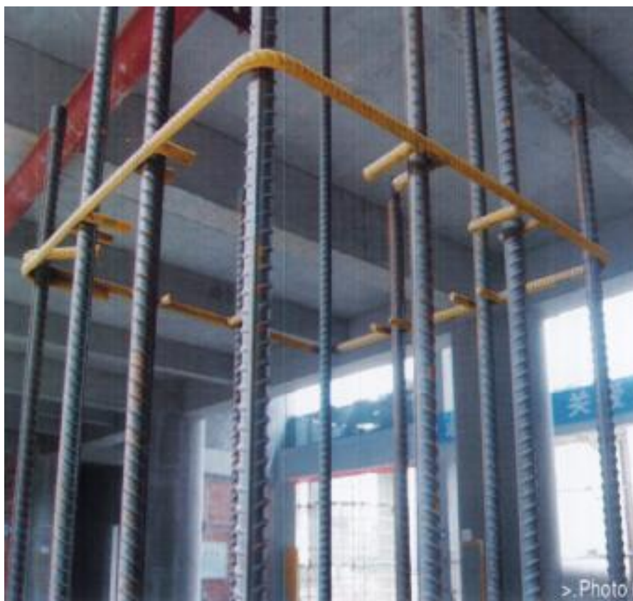
框架柱定位筋
