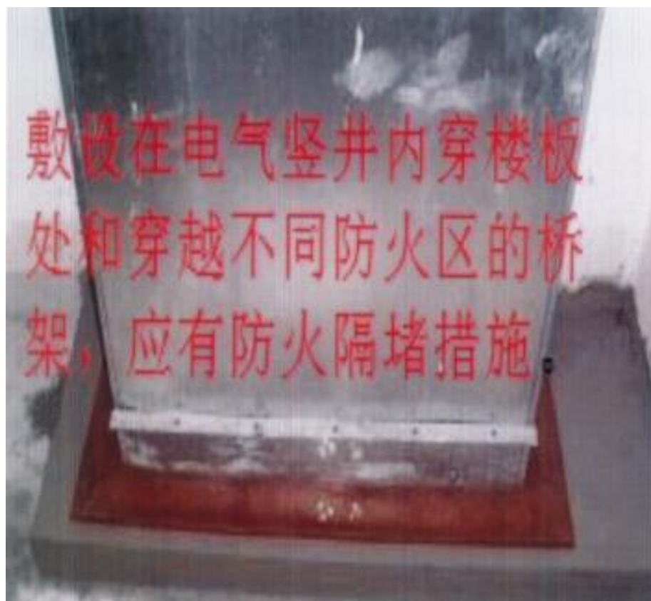
电缆井布置及封堵
