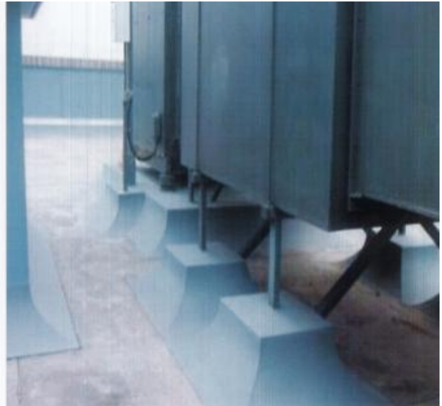
屋面排水口篦子以及设备基座护墩样板
